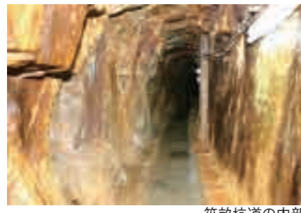
箕畝坑道の内部
