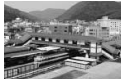
備中高梁駅東西連絡道
