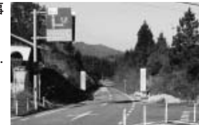
整備された農道
