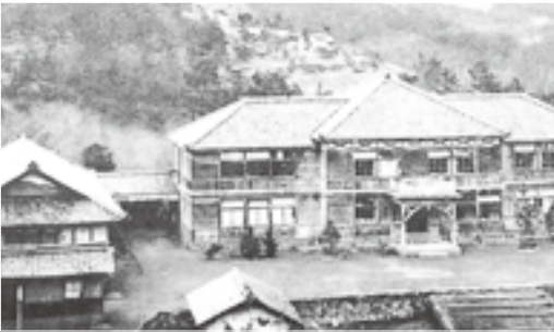
一部改修された昭和4年の校舎
