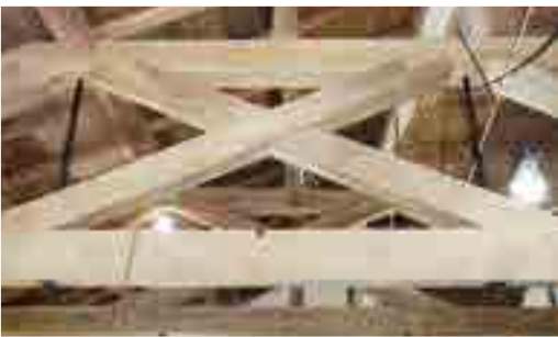
三間廊下のトラス(骨組み)
