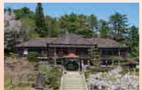
旧吹屋小学校校舎本館(修理前)
