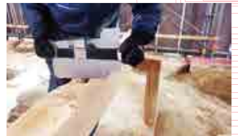
かたと型取りによる土台調整
