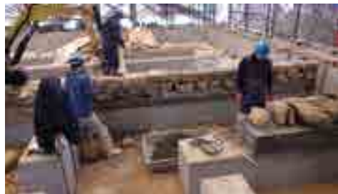
割石積布基礎の再構築
