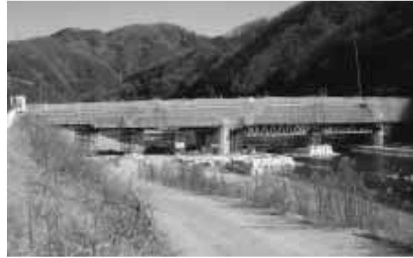
工事が進む新しい橋
