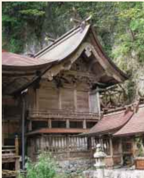
本殿(県指定重要文化財)
