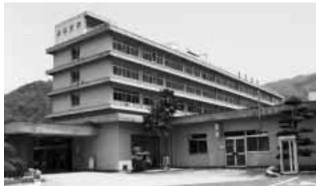
改築予定の成羽病院
